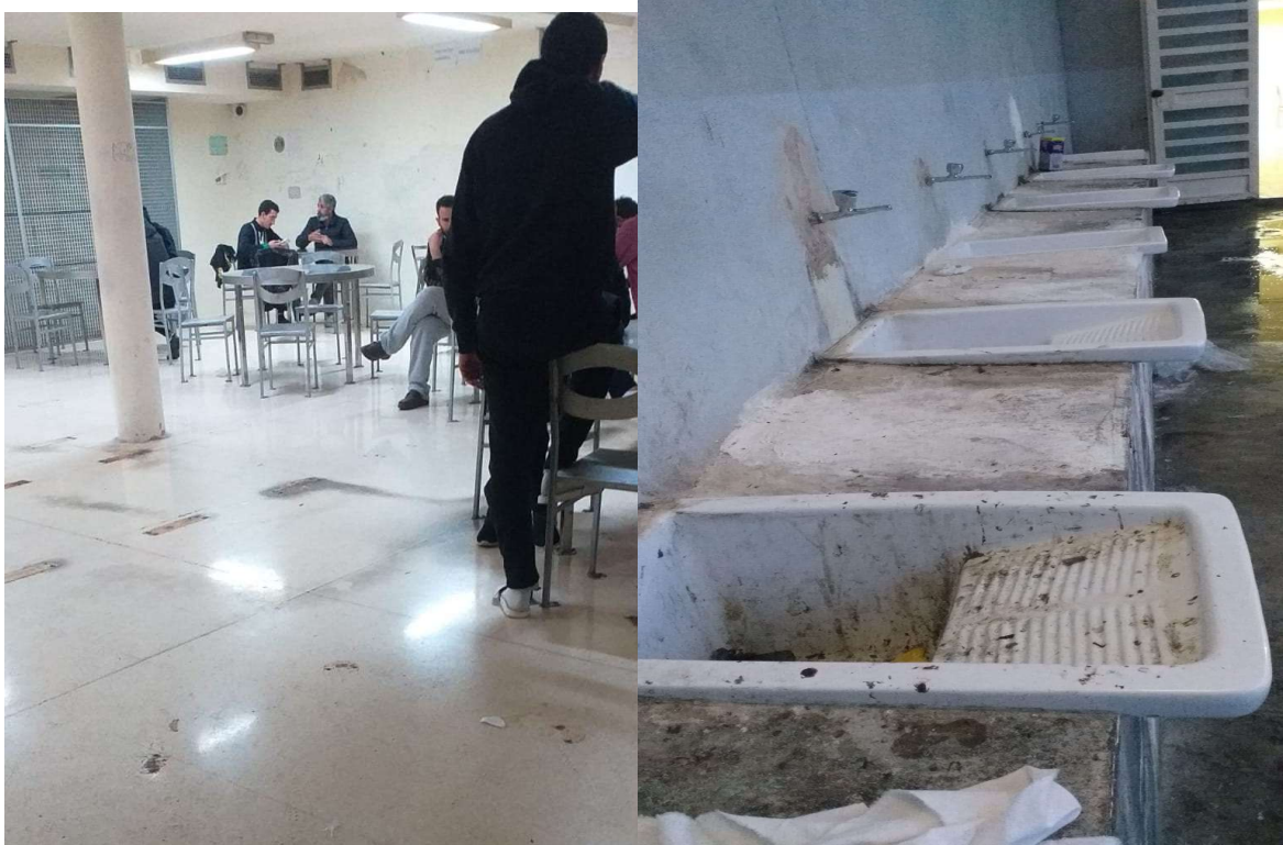
Lugar habilitado como espacios comunes y lavadero en el patio del CIE de Murcia.
